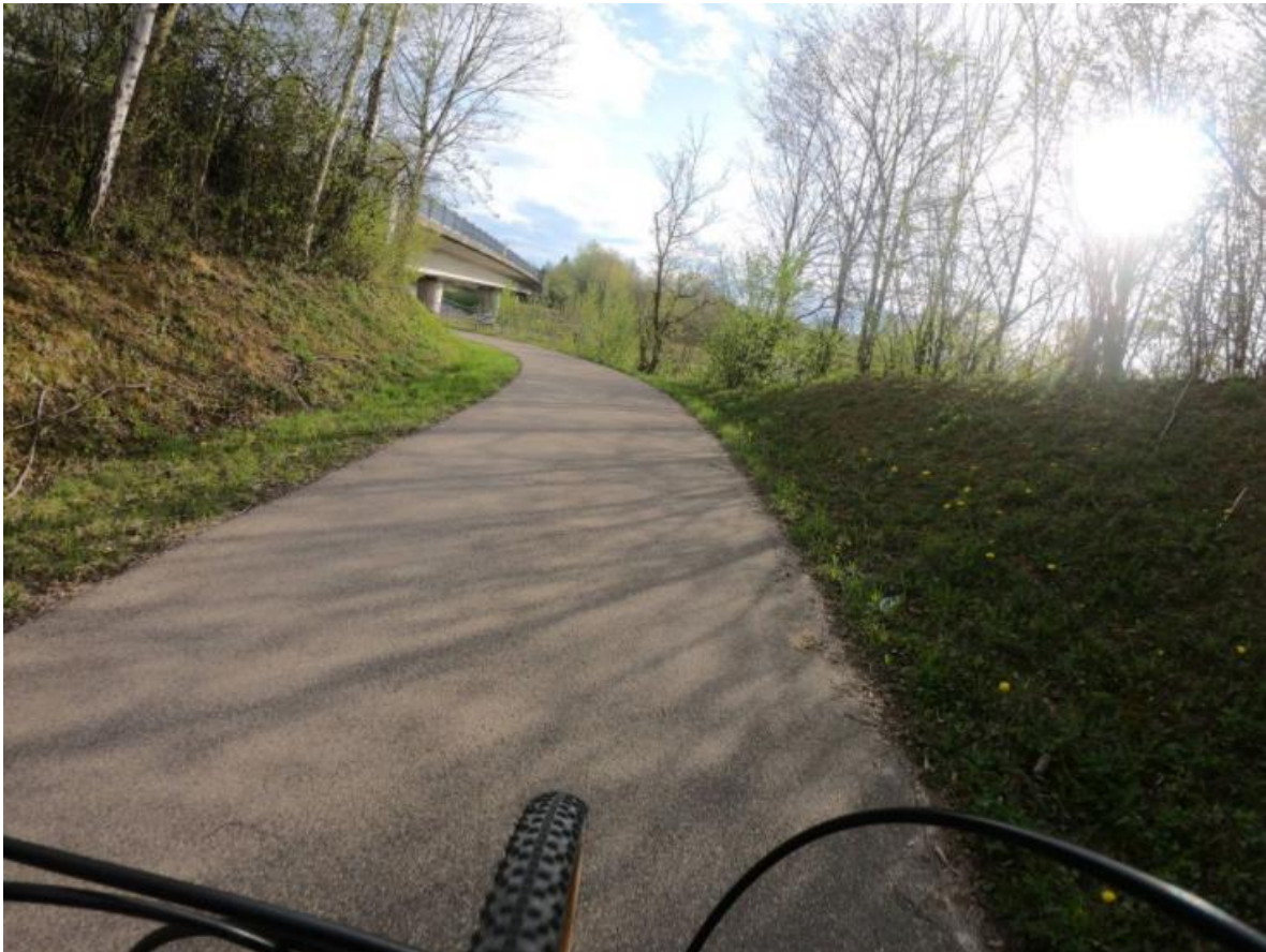
Abbildung 3-17: Unterführung an der Basler Straße
