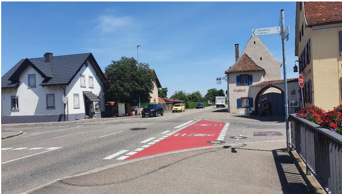
Abbildung 3-12: Querung an der Weingartenstraße in Buggingen
